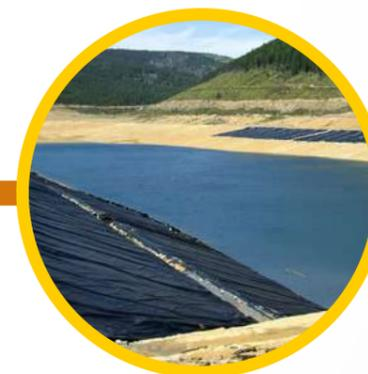
Медный, свинцовый и цинковый концентраты сгущаются в ходе двухступенчатого процесса обезвоживания. Отработанная пульпа (хвосты) сгущается и перекачивается в хвостохранилище.
